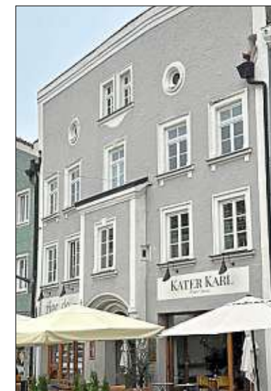
Das Wohn- und Geschäftshaus am Stadtplatz wurde drei Jahre lang aufwendig umgebaut und saniert.
